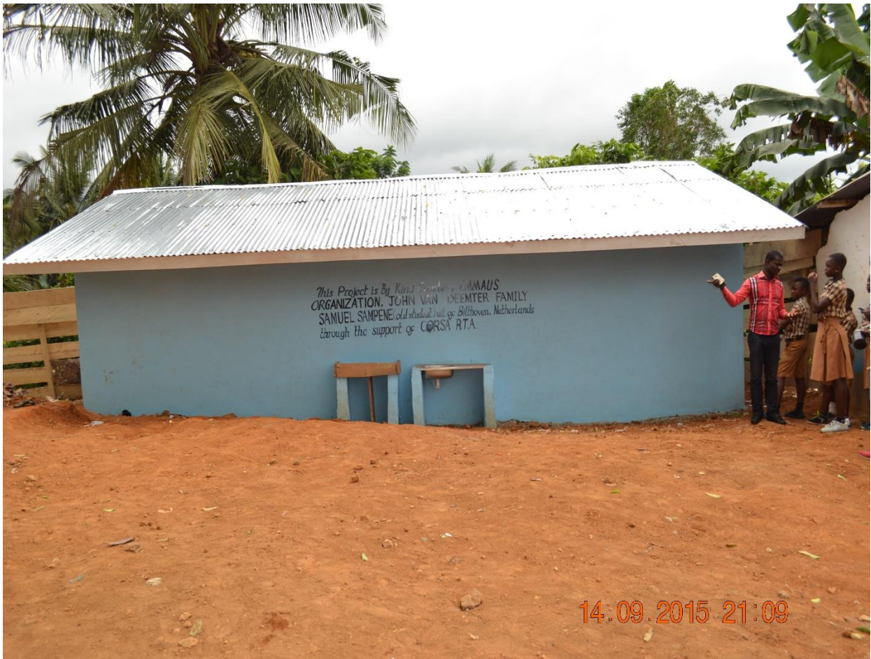
Het nieuwe toiletgebouw met 16 wc's en wasbakken is gereed.
