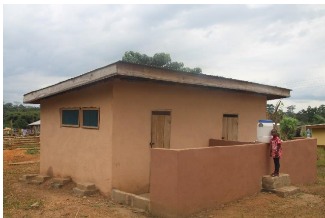
Oplevering nieuwe toiletgebouw Njetina
