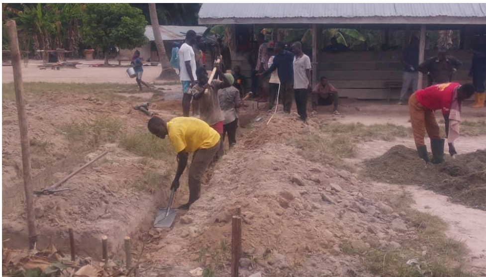
Ouders helpen de funderingsruimte te graven
